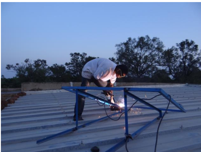
Das Gestell für die PV-Module wird fest mit dem Dach verschweißt
