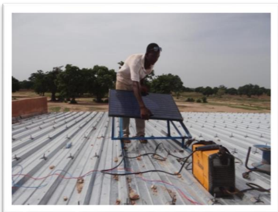
Montage des Solarmoduls
