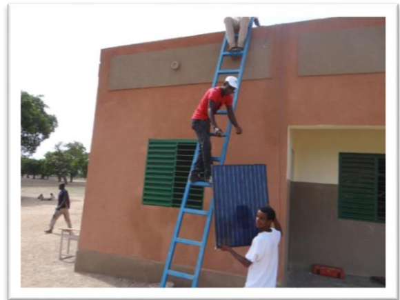
Das PV-Modul wird aufs Dach befördert
