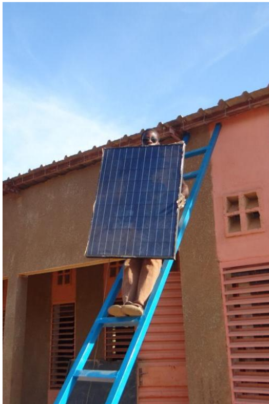
Das Photovoltaikmodul wird aufs Schuldach befördert
