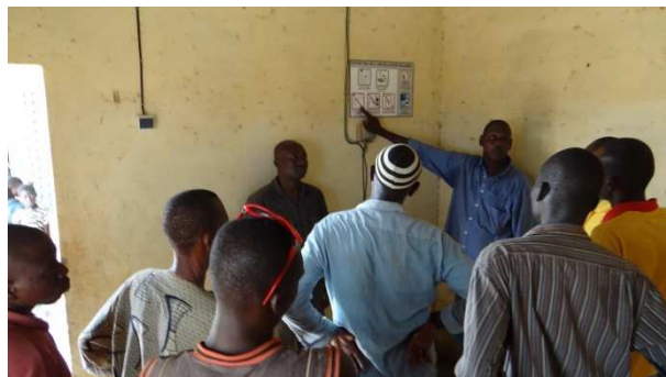
SEWA-Mitarbeiter Yéral Dicko erklärt die Wartung der Solaranlage
