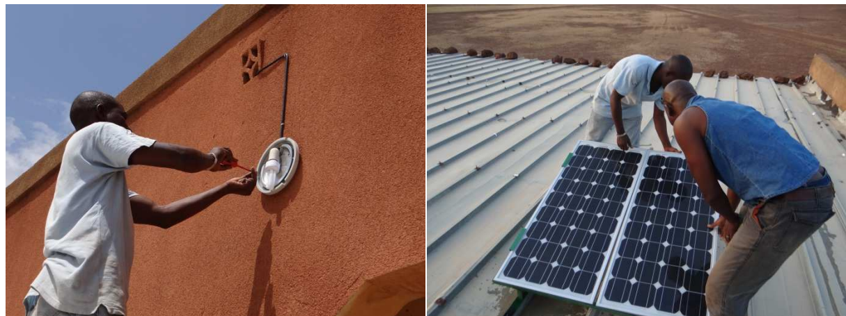
MicroSow Mitarbeiter beim Anbauen der Außenbeleuchtung und beim Einsetzen der Solarpaneele
